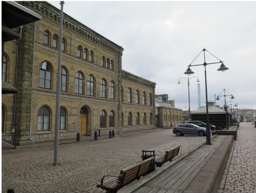
Figur 8: Det fördetta Tullpackhuset som uppfördes 1864–67 och som gett kajen dess namn. Bild/bildtext från Kulturmiljörapport Packhuskajen 2018:02, sid 11.
